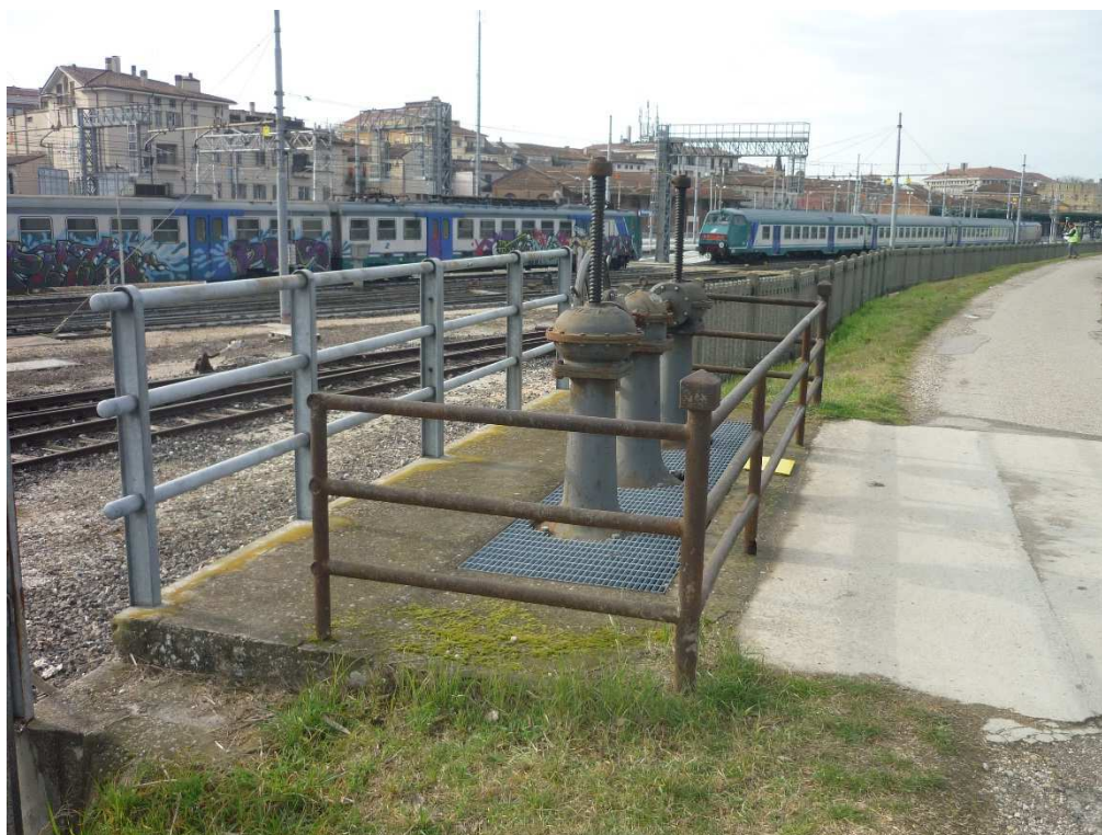
Figura 14: Chiavica del rio di Mantova. Vista da est lato opposto ciclabile. Organi di comando seconda fila di paratoie di regolazione.
