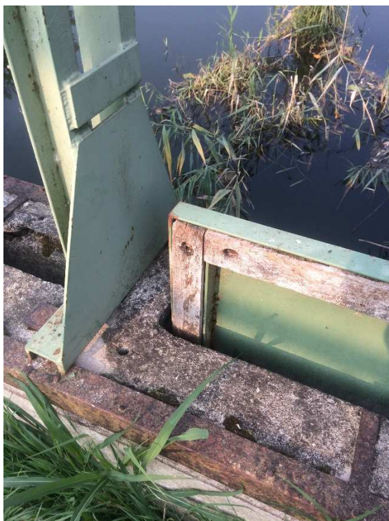
Figura 9: Chiavica del rio di Mantova. Particolare diaframma paratoia.
