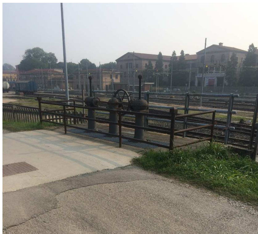
Figura 12: Chiavica del rio di Mantova. Vista da ovest lato opposto ciclabile. Organi di comando seconda fila di paratoie di regolazione.
