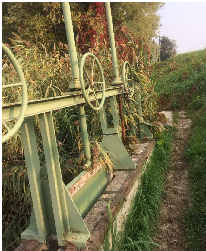
Figura 7: Chiavica del rio di Mantova. Particolare opere meccaniche di movimentazione paratoie.
