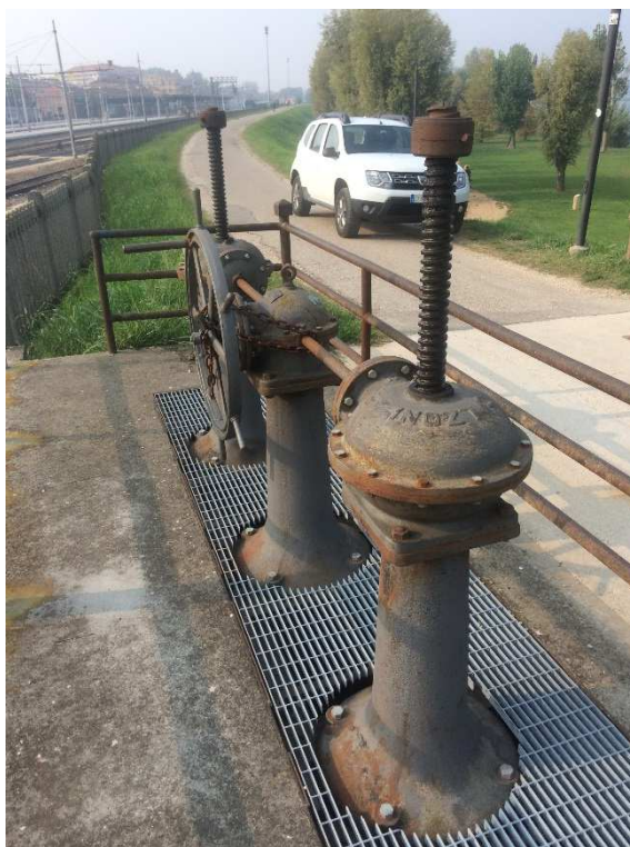
Figura 13: Chiavica del rio di Mantova. Vista da est lato opposto ciclabile. Organi di comando seconda fila di paratoie di regolazione.
